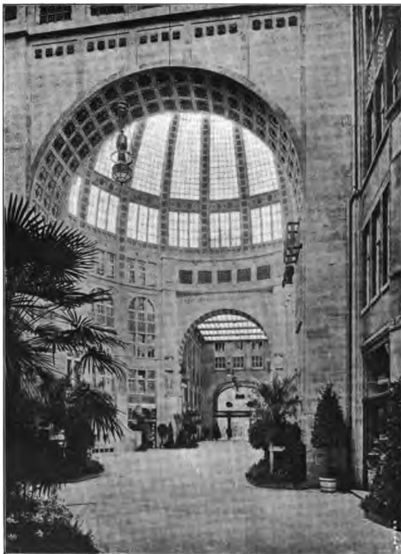
Abb. 76. Friedrichstraßen - Passage in Berlin. Innenansicht des Kuppelraumes.
